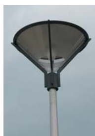
Éclairer le sol plutôt que le ciel : luminaire réflecteur à Mamirolle.
