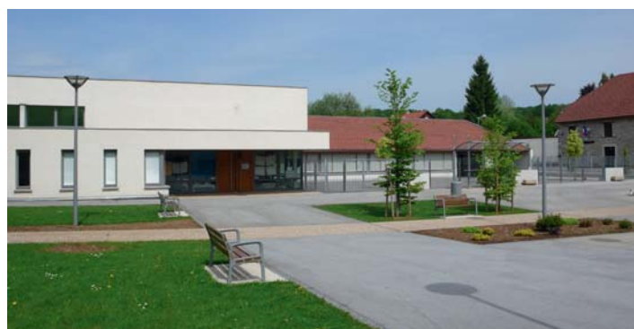
Aménagement de centre village : école primaire et mairie rénovée à l'Hôpital-du-Grosbois.
