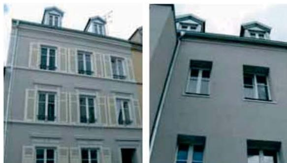
Rénovation thermique de logements à Mulhouse : isolation par l'intérieur des façades sur rue et isolation par l'extérieur des façades sur cour (15 cm de polystyrène).
