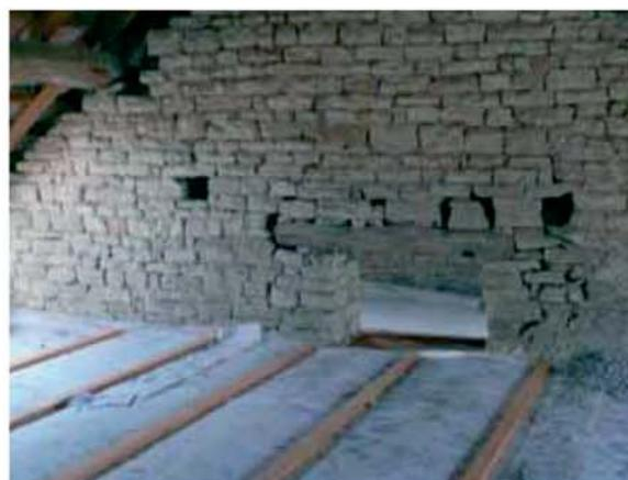
Rénovation et isolation de combles non aménagés à Hugier (Haute-Saône) : 30 cm de ouate de cellulose en vrac sur le plancher des combles.
