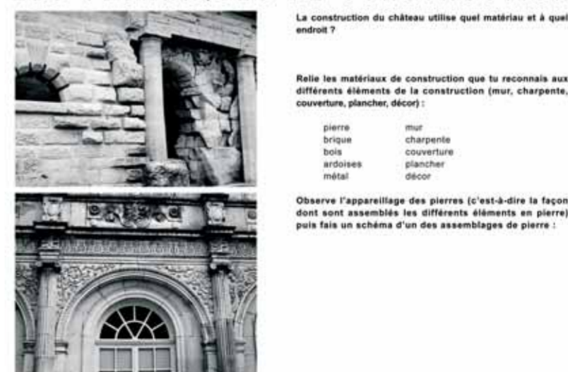
L'atelier tournant « construction » : rechercher les matériaux utilisés et repérer leur mise en œuvre, puis à partir de l'observation des façades, rechercher les deux façons de franchir un vide (la plate-bande et l'arc).
