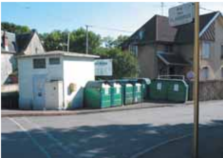
Dans un carrefour : inaccessible et gêne des déplacements.
