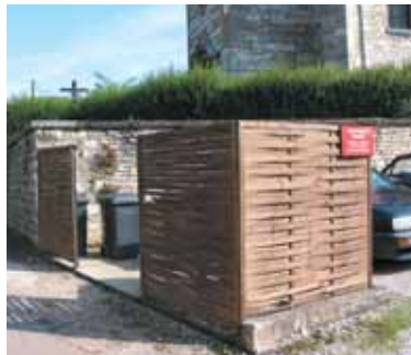
Création d'un claustra.
