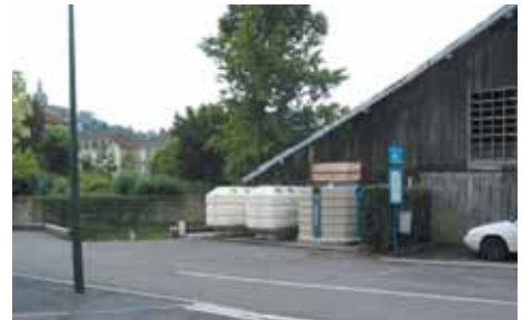
Absence d'aménagement et d'intégration au cadre bâti.
